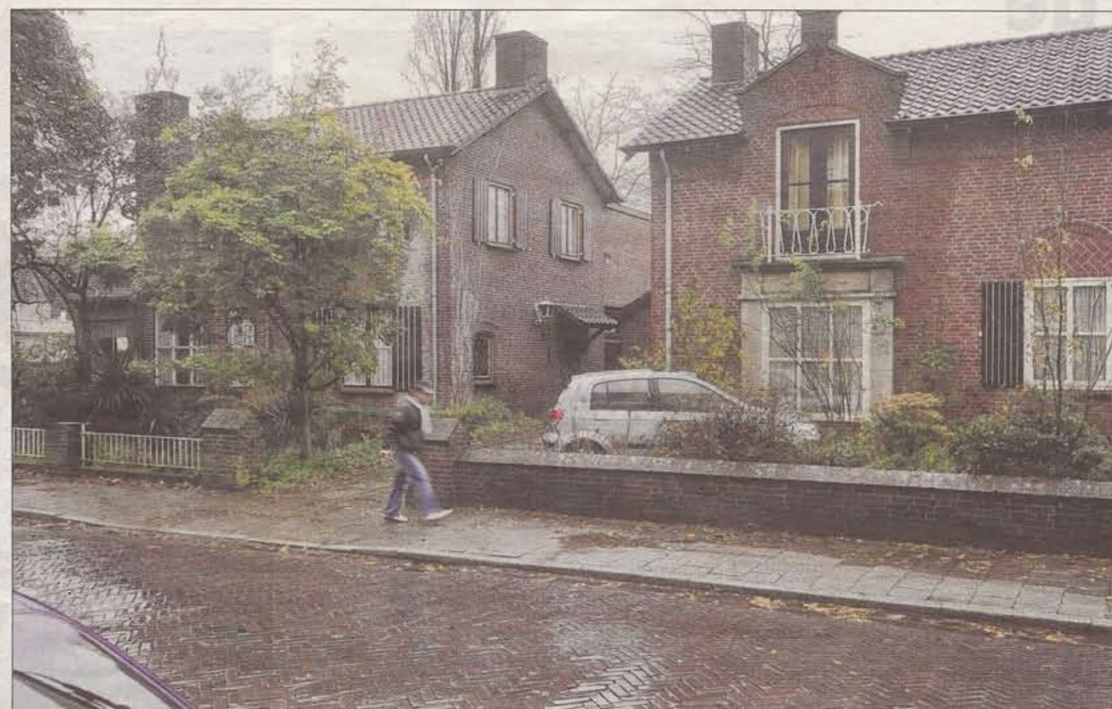
De twee karakteristieke huizen aan de Julianastraat gaan tegen de vlakte. PR Bouw uit Uden wil er twintig appartementen realiseren. foto Jeroen Appels/Van Assendelft
